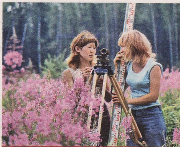
Геодезисты во время съемки на строительстве Усть-Илимского целлюлозного комбината
