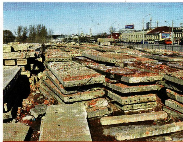
Недострой снесен. Остались одни бетонные плиты
