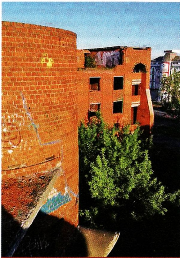
На стенах недостроенной гостиницы
