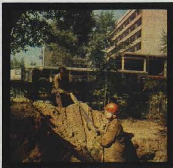
НА ПОЛИГОНЕ. РАБОТА С «КРОТОМ» ПОД КРАСНЫМ ПРОСПЕКТОМ В НОВОСИБИРСКЕ.
