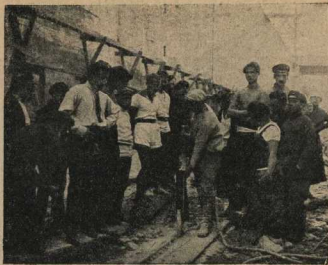
Бурильные работы на дне шлюзового канала.
