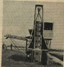
МЕХАНИЗАЦИЯ НА ТОРФРАЗРАБОТКАХ. Торфяная баггер Экслунда.
