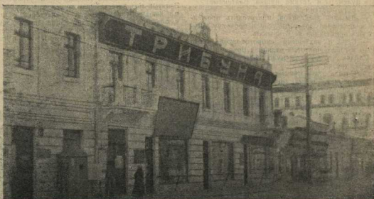
ХАРБИН: здание, в котором помещалась закрытая рабочая газета «Трибуна»
