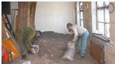
Шлак с опилками вновь пошел на утепление потолка
