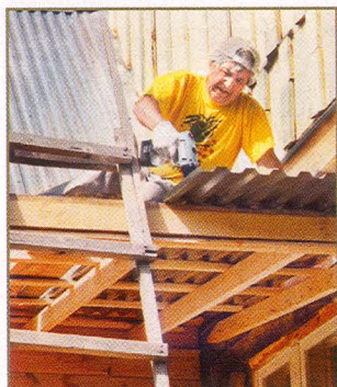
Хозяин дома монтирует оцинкованный профиль
