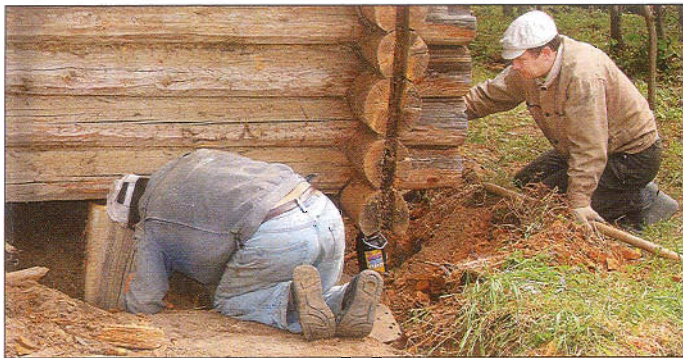
Для установки домкратов рабочие сначала делали подкоп
