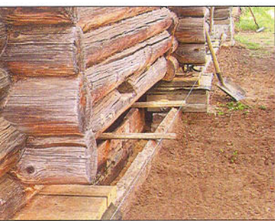
Опалубку по всему периметру дома заливали бетоном в течение недели
