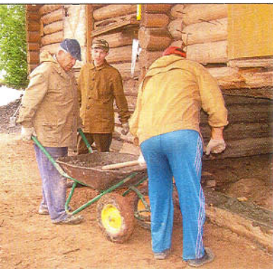
Для доставки бетона к нужному месту фундамента использовали тачку на больших колесах
