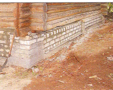
Пустоты после удаления подгнивших бревен закрыли кладкой
