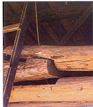
Так выглядел до ремонта деревянный замок для стыковки верхних балок
