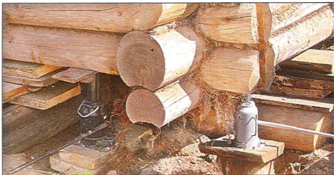
Подняв угол до нужного уровня, домкраты заменяли кусками бруса и досок
