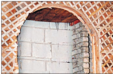
Арочный проем после набивки дранки
