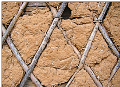
В Сибири сохранились дома, в которых стены оштукатурены глиной по ивовым прутьям
