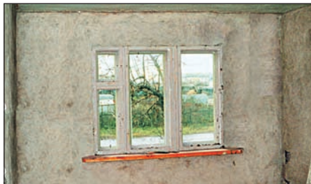
Стена после затирки глинопесчаным раствором
