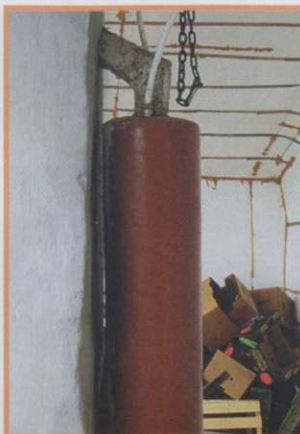
Печь из толстой листовой стали и водогрейный котел сконструированы специально для обогрева теплицы
