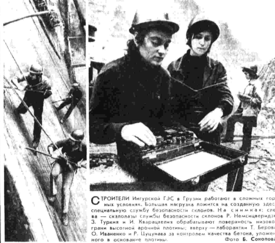
СТРОИТЕЛИ Ингурской ГЭС в Грузии работают в сложных горных условиях. Большая нагрузка ложится на создание здесь специальную службу безопасности склонов.
