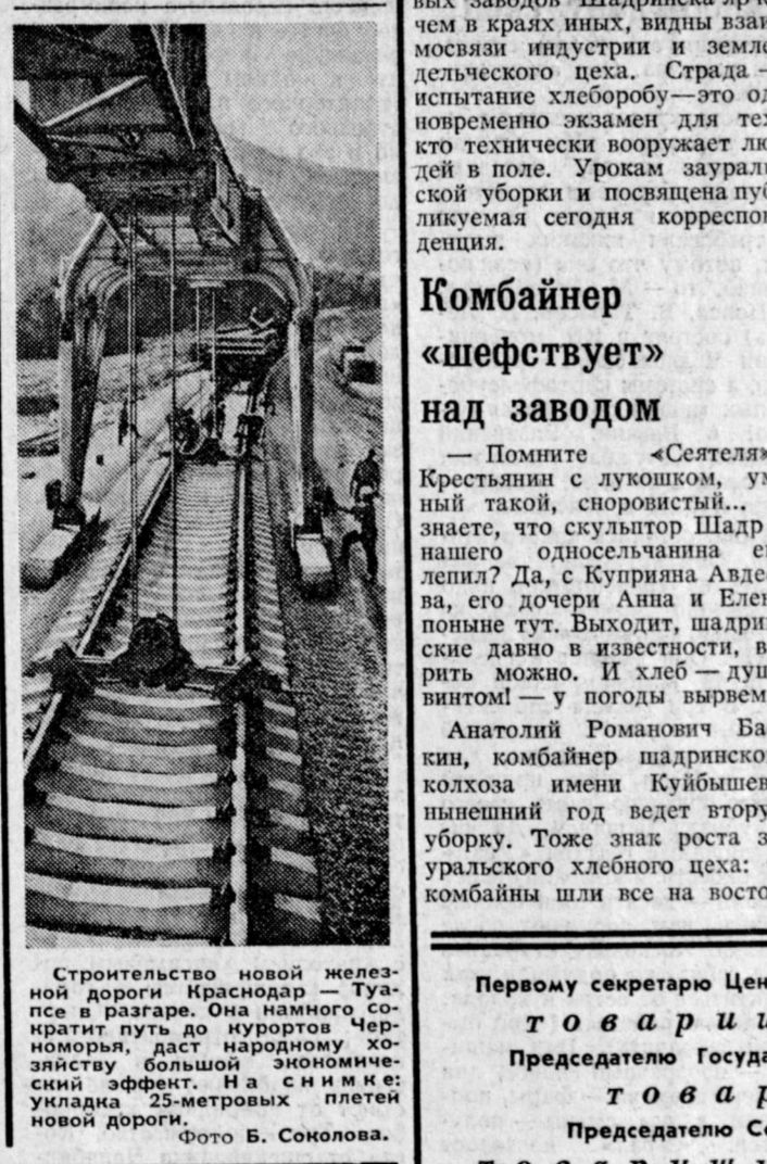
Строительство новой железной дороги Краснодар — Туапсе в разгаре. Она намного сократит путь до курортов Карматорья, даст народному хозяйству болевший экономический эффект. На снимке: укладка 25-метровых плетей новой дороги. Фото Б. Соколова.
