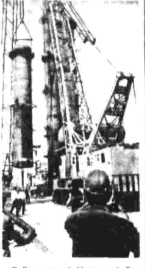
В Венгерской Народной Республике создается крупный центр нефтехимии в Лемнигашо. При содействии Советского Союза здесь строится завод по выпуску olefinов — сырью для изготовления пластмасс. На снимке: установка рефракционной колонны на строительной площадке. Фото МТИ — ТАСС.
