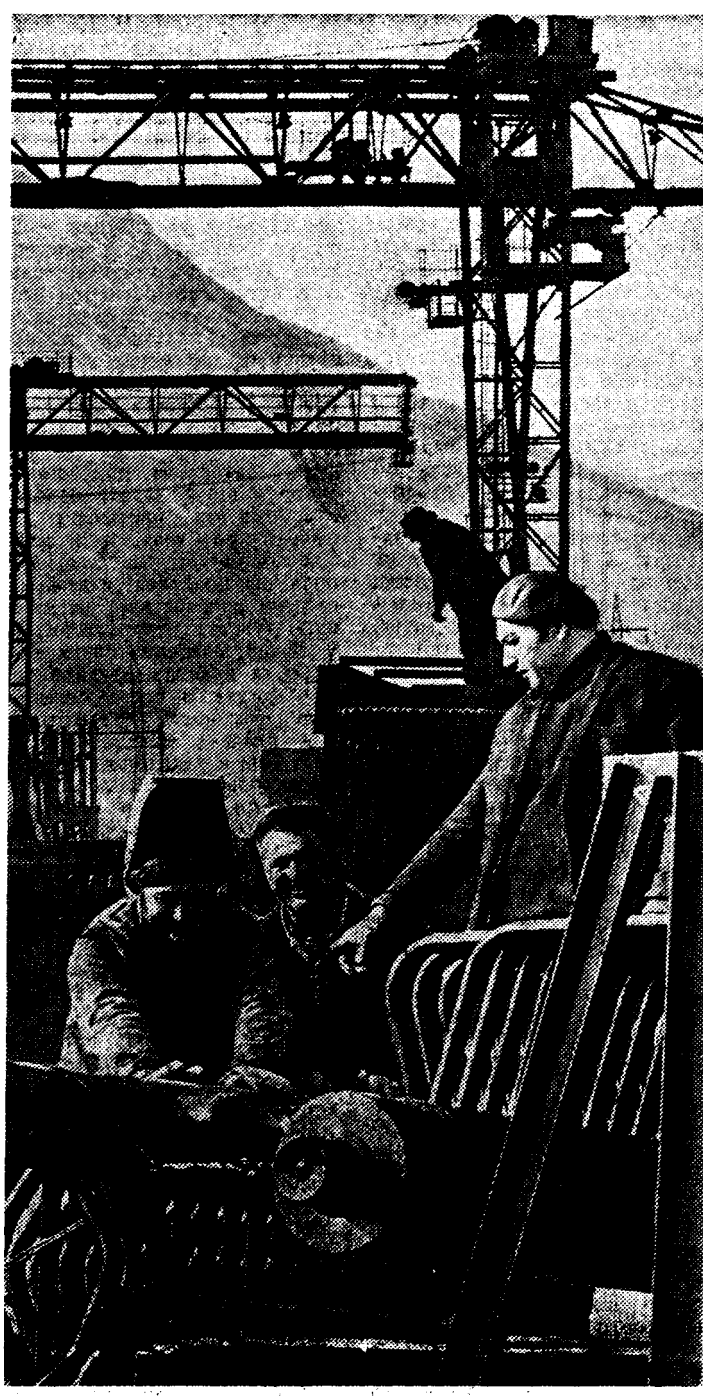
В горах Армении строится крупнейшая в Закавказье Радикальная ГРЭС. Первая ее очередь — три блока по 200 тысяч киловатт каждый — уже вышла на проектную мощность. Сейчас сооружается вторая очередь. На снимке: бригада треста «Кавказэнергомотаж», руководимая Григорием Гуляном, за сборкой перегревателя высокого давления (слева направо): Н. Мовсисян, А. Захарян и Г. Гулян.
