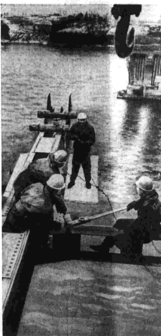
С ПЛОЩАДИ близ Толстого мыса ГЭС возводятся Усть-Илимская ГЭС, хорошо видны амурные конструкции строящегося моста через Амгунь. Его сооружает коллектив треста № 2 Главмостострой. На с ним и здание В. И. Ленинки ведет монтаж очередного пролета.
