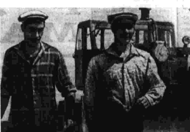
На строительстве бригады Талал Овсаев, Аман Агаев, Джума Маммадулов, Бекен Курбанов, Курбан Овса Худайбаев; разработку котлована конкольного перепада ведет бригада депутата Верховного Совета СССР Джума Кичиева. Фото А. Шамова.
