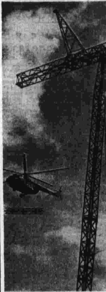
ОДНА из других поднимается мачта линии электропередачи Толеж — Александровское, протянувшаяся по тайге на севере Томской области. Строительство ЛЭП-220 ведет трест «Сибэнергострой». Мониторинг помогают вертолетчики.
