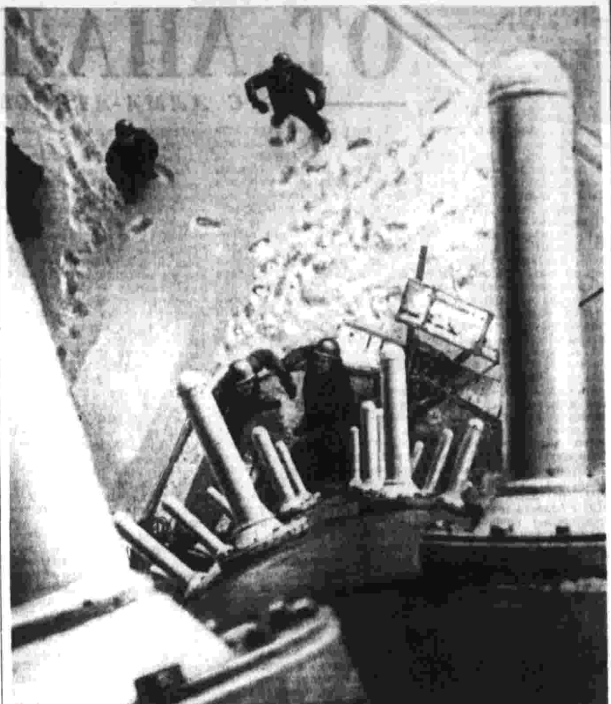
В столице Украины — Киеве строится башня нового телевизионного центра. Это будет гигантское цельносварное сооружение высотой 385 метров.
