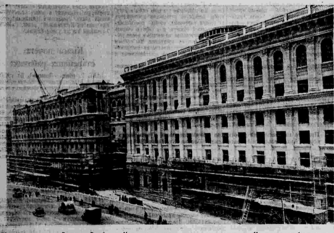
К 31-й годовщине Великой Октябрьской революции в Москве заканчивается сооружение новых домов. На снимке: освобождающиеся от строительных лесов дома на улице Горького.
