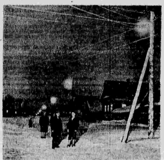
Колхоз им. Коминтерна, Оршанского района, Марийской АССР, построил свою гидроэлектростанцию. На снимках: 1. Вечером на деревенской улице. 2. Колхозники слушают трансляцию на радиоузел.
