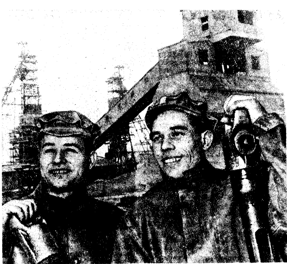
В ближайшее время в Донбассе будет пущена мощная шахта «Пролетарская-Крутая», построенная в этом году. На снимке: сталхановы проходчика шахты: С. Щербак (слева) и В. Федотов. Их бригады выполняют план на 200—250 проц. Фото Дробота (Фотохроника ТАСС).
