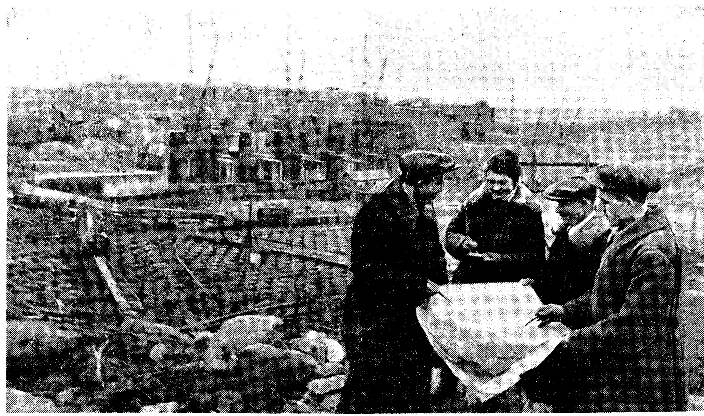
На строительстве Рыбинского гидроузла. На снимке (слева направо): стахановцы-прорабы П. Т. Бирнбаум, А. Я. Волгова, А. Н. Антипин и Л. Н. Яценко. Фото М. Бернштейна.
