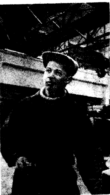
На Сегезском бумажно-целлюлозном комбинате (Жарьский АССР) полостью закончен монтаж оборудования первой очереди. На снимке: стахановский монтажник Я. К. Пашуков, выполняющий норму на 300 процентов.
