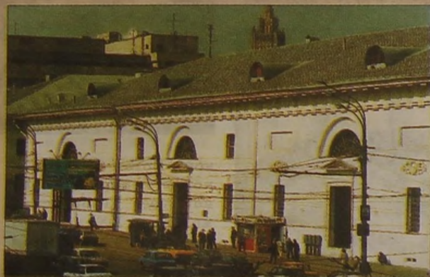
Провиантские склады. Они выстроены в 1829-1831 г. Ф.М.Шестаковым. Ограды между зданиями — с мотивами военной атрибутики.
