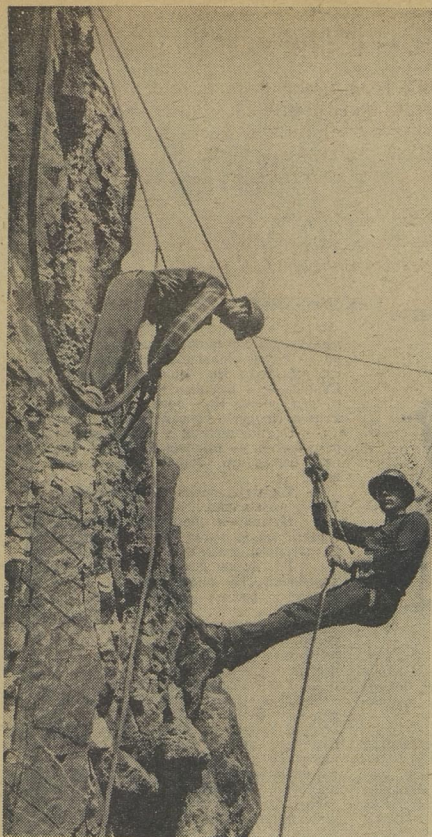
На высоте птичьего полёта работают скалолазы-монтажники Владимир Самонов и Виктор Сорочкин. Они готовят место для стальных опор высоковольтной линии, по которой в города и села пойдёт ток Токтогульской ГЭС.
