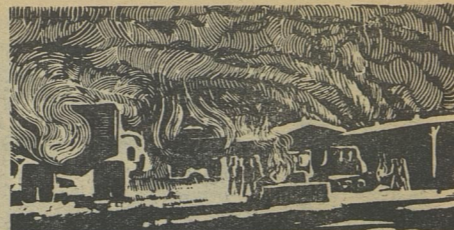
Утро на 3-м строительном участке.
