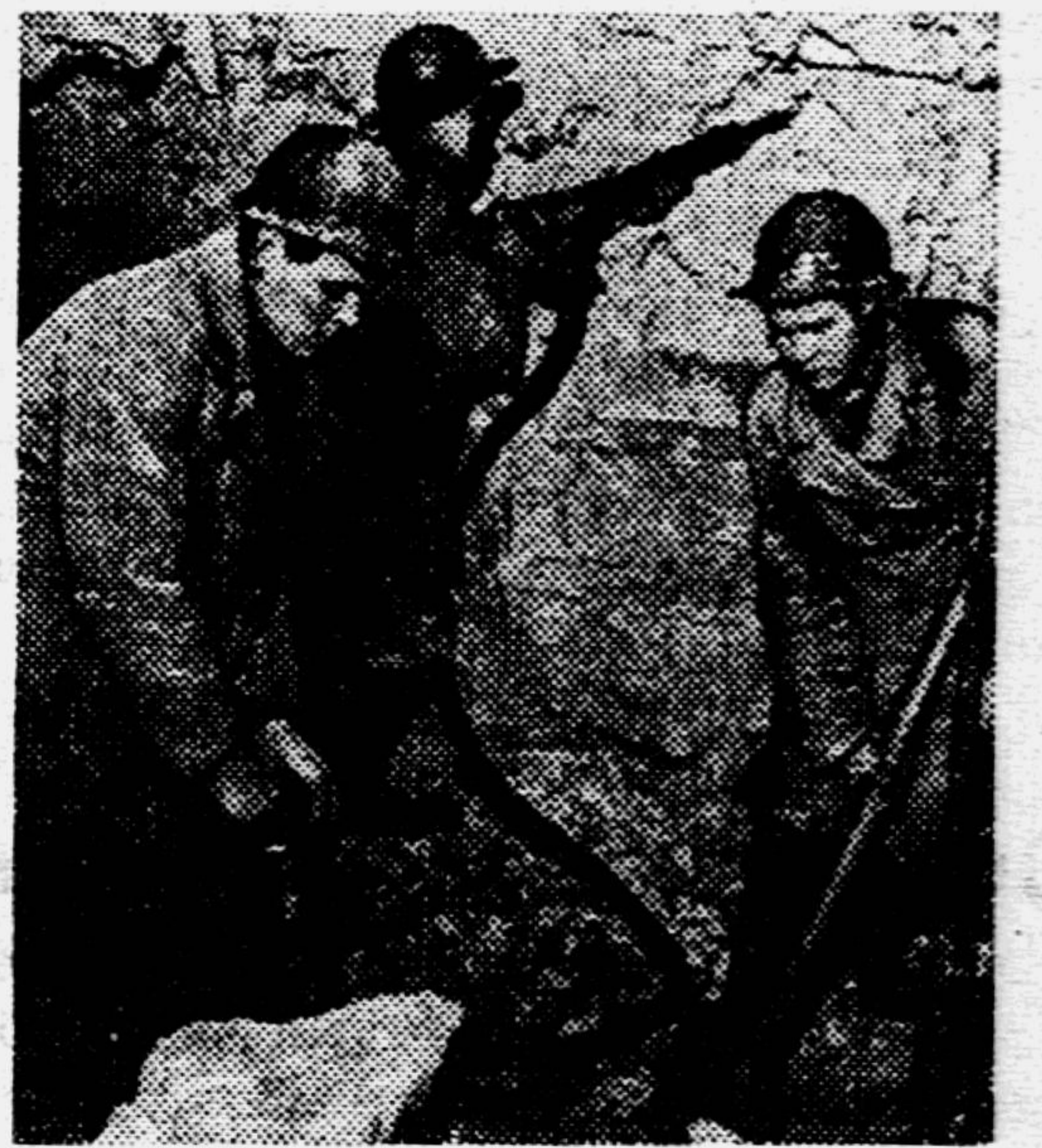
В Москве строится четвертая очередь метрополитена. На этом снимке вы видите, как под землей работают проходчики.
