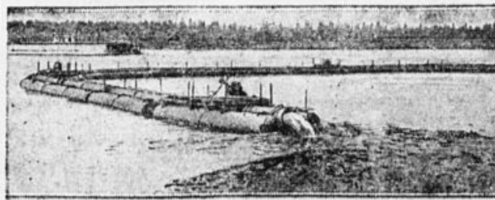
Свиристрой строится. Отводные трубы землесоса Озерного № 4, выбрасывающие взятый землесосом грунт.
