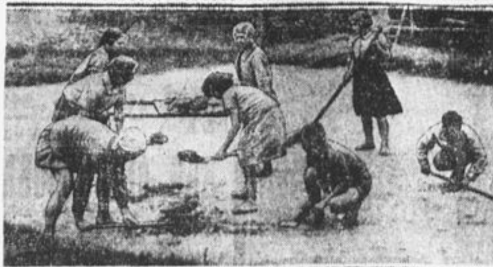
За устройством площадки.
