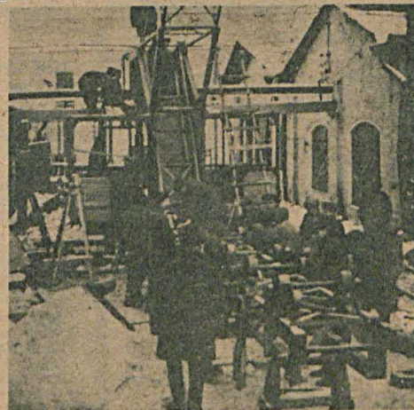
Первый советский экскаватор. Монтаж 21-ковшевого экскаватора на заводе «Красный металлист», выдвигшем первый советский экскаватор ранее срока. С 1932 года завод переходит на массовый выпуск Фот. С. Шнигарева
