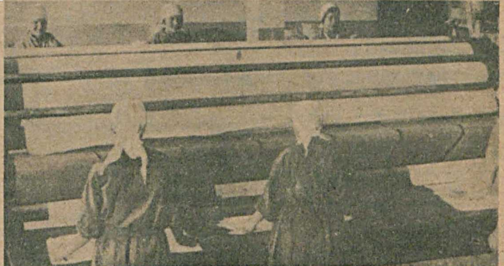
Механизированные прачечные освобождают труд работниц. Глажение белья в Москве в механической фабрике-прачечной. Восемь работниц пропускают в одну смену 1.200 килограмм белья
