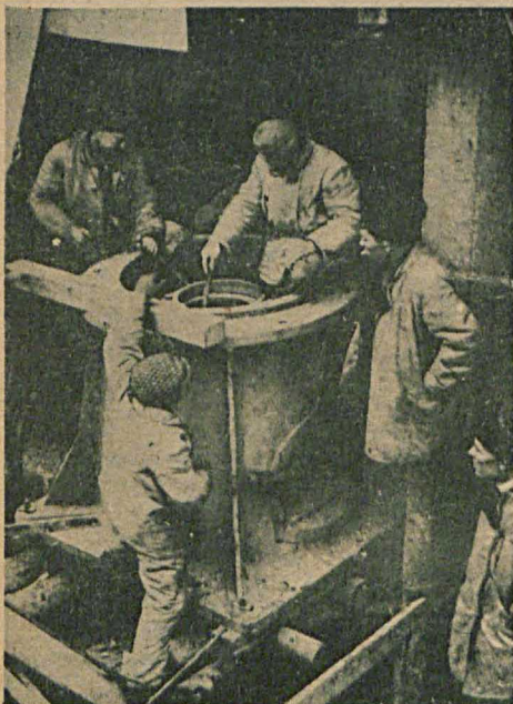
На ударных стройках Московской области. Закачивается монтаж основания мельницы шломотного завода Вобриковского химкомбината
