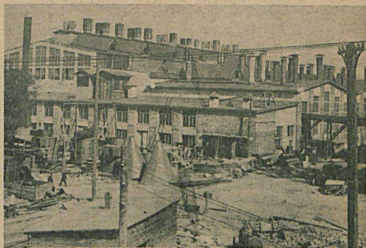
Строительство «Красного Путиловца». На заводе «Красный путиловец» в Ленинграде вступили в строй вновь выстроенные: тракторно-чугунная мастерская, литейная, мощностью в 18 тыс. тонн литья в год, турбинный корпус и термическая мастерская. На с н и м к: новая термическая кузница тракторного завода
