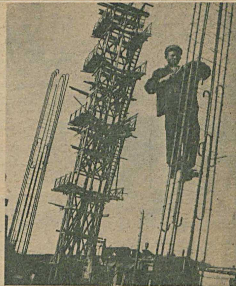
Новый завод в Средней Азии. Установка арматуры на стройке нового цеха Ташкентского седьмашестрса, который будет снабжать машинами всю Среднюю Азию
