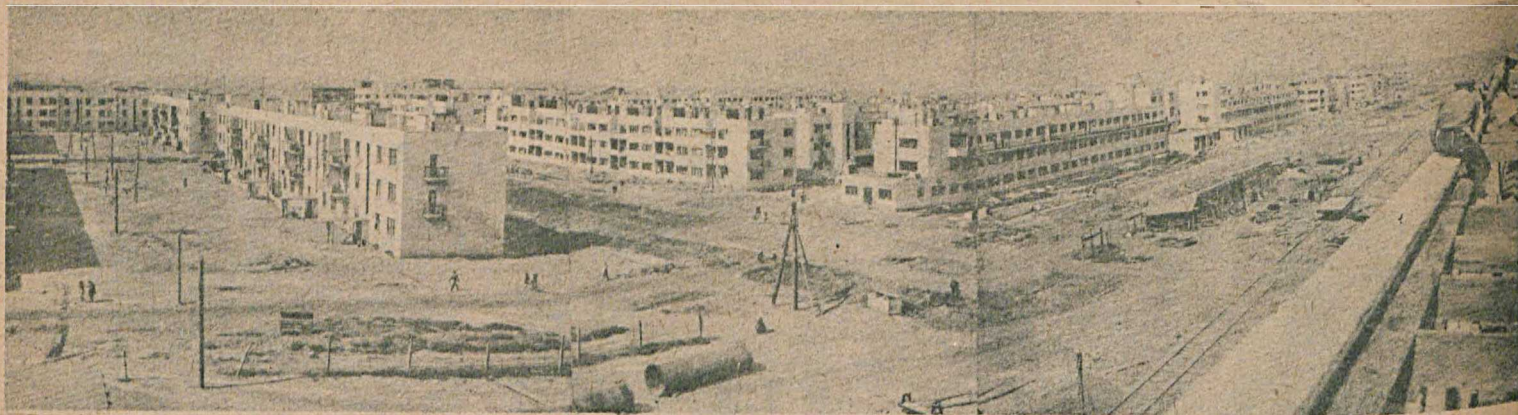
Все участники объединенного Днепровского строительства включились в Сталинскую эстафету. Рабочие и инженерно-технический персонал строительства мартеновского цеха обязались к 14-й годовщине Октября забетонировать 5.500 метров и начать бетонировку электро-мартеновского цеха
