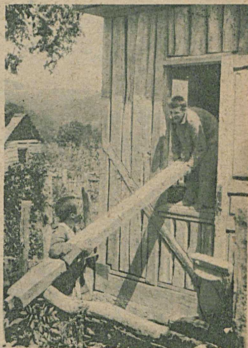
Пример деловой подготовки к началу учебного года показал колхоз Шкафит (Шапсугский район, Северный Кавказ). Колхозники выделили бригаду и вместе с ребятами достроили здание школы, тем самым обеспечив своевременное начало занятий. На снимке: колхозники на постройке школы
