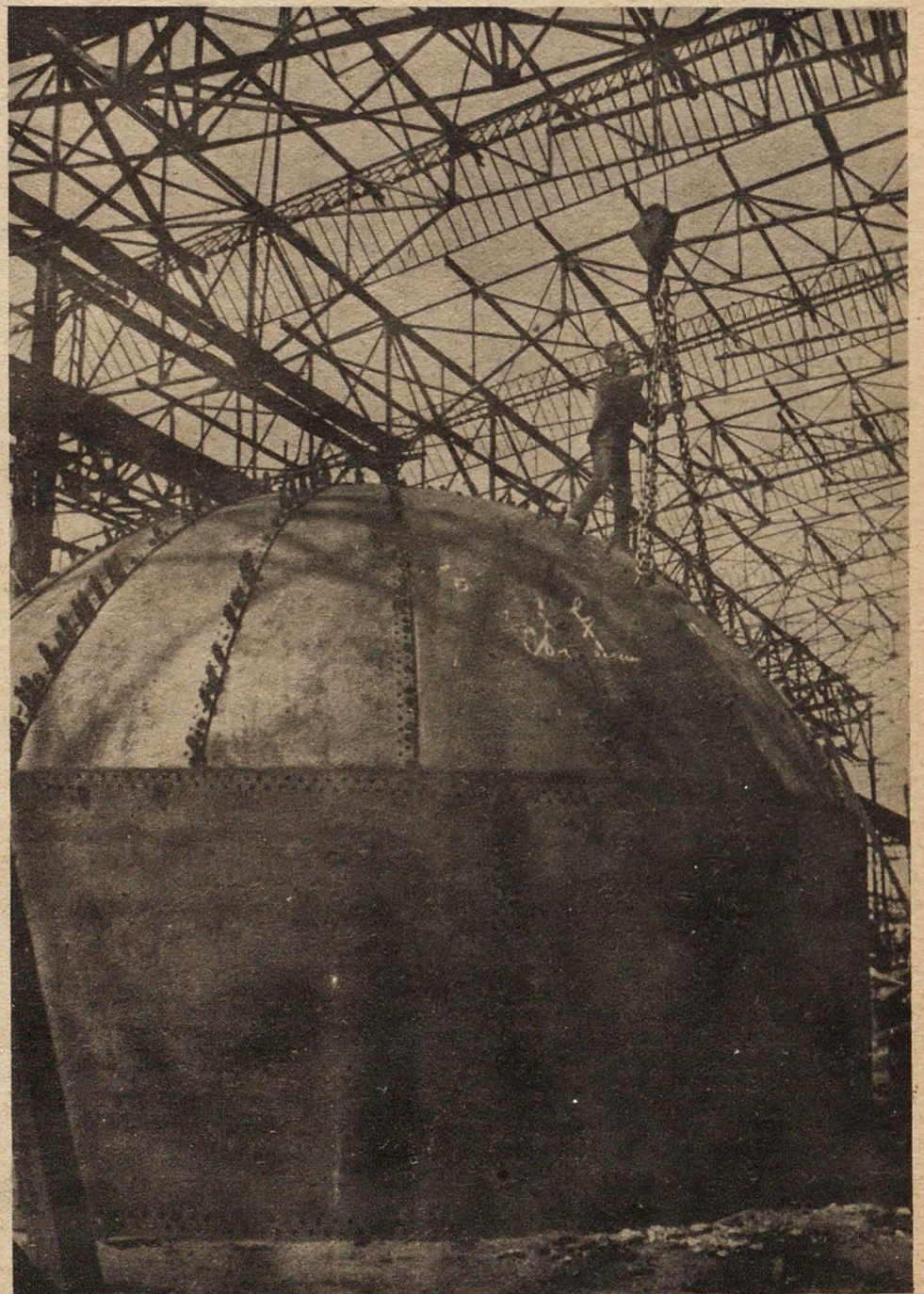
Сборка шапки каупера к домне для Магнитостроя на Днепропетровском мостовом заводе им. Молотова
