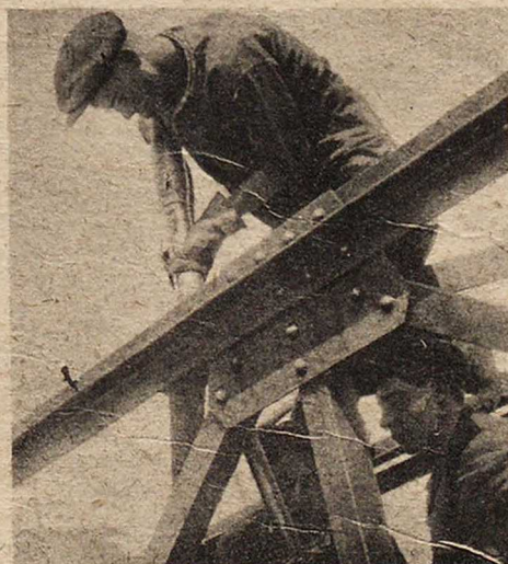
Ученики 18-й школы ФГУ Сталинградского завода изучают работу клепального пневматического молота немецкого образца
