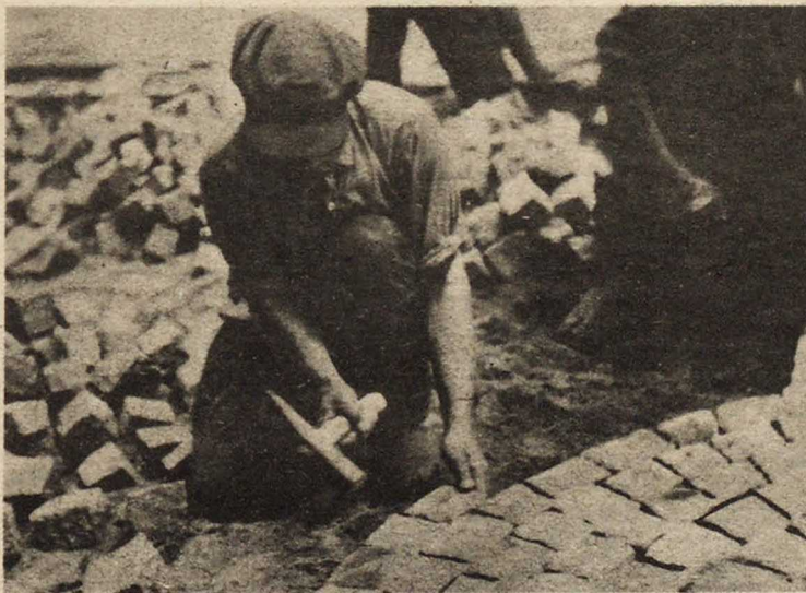
Укладка брусчатки на Б. Дмитровке
