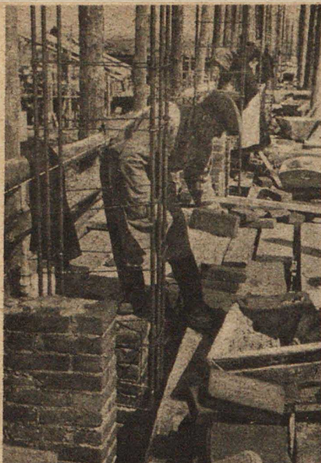
На стройке железо-заготовительного цеха сибирского завода комбайнов (Ново-Сибирск)
