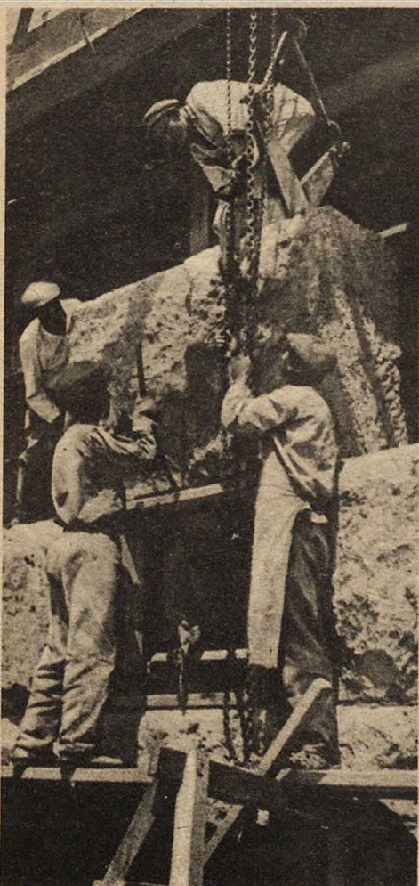
Кладка стен ГЭС Днепронетровского комбината
