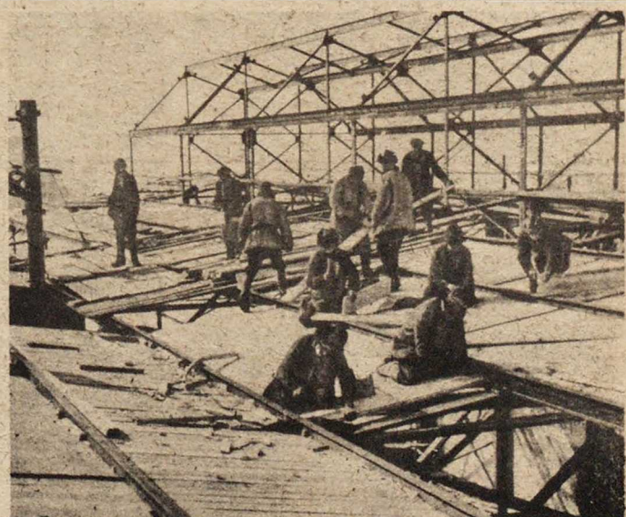
Настилка крыши механо-сборочного цеха Нижегородского автозавода
