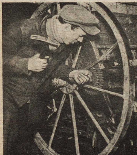
Слесарь-ударник Владыкинской с. х. артели Клинского района тов. Антонов, за ремонтом сеялки фот. Н. Васильева
