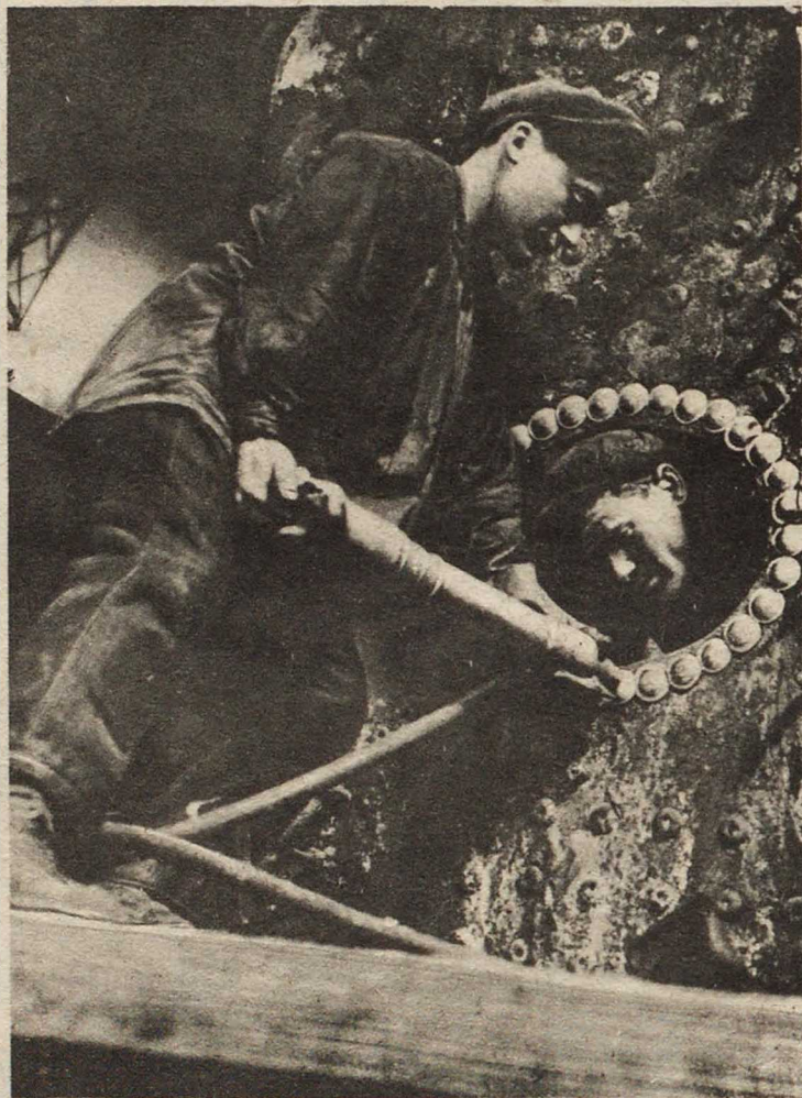
Все на улучшение транспорта. Лучшие ударники котельного цеха Ташкентского завода тт. Павленко и Абдулаев на горячей клепке
