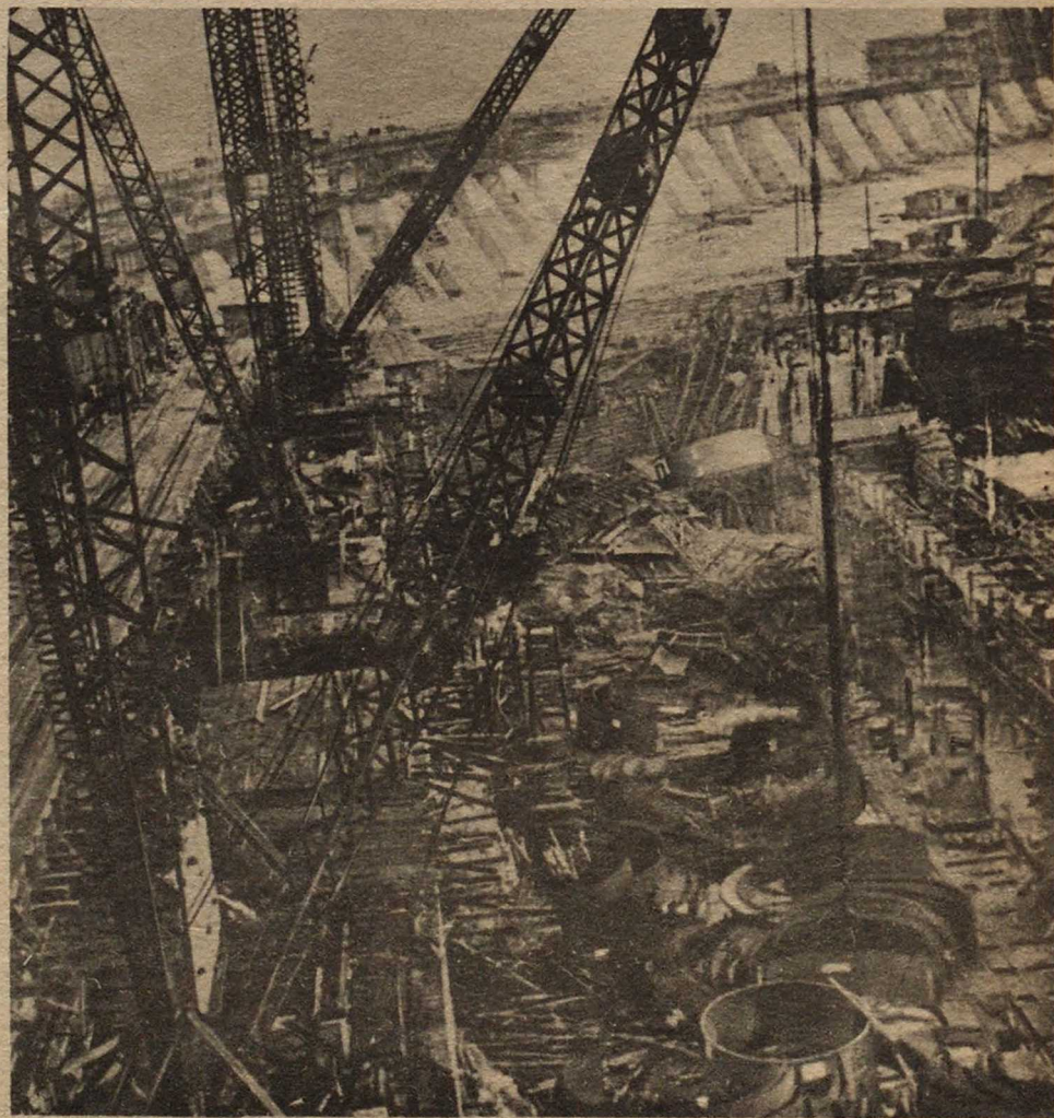
Сегодня на Днепре. Поднятые большевистские темпы, принятые ударниками Днепростроя, гарантируют окончание строительства в срок. На с и м к е: опалубка для генераторов
