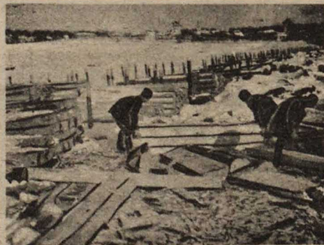
Начало сплава. Заготовка шпал и укладка их в кошелю на берегах Волги в Угличке Фот. Н. Черелякина
