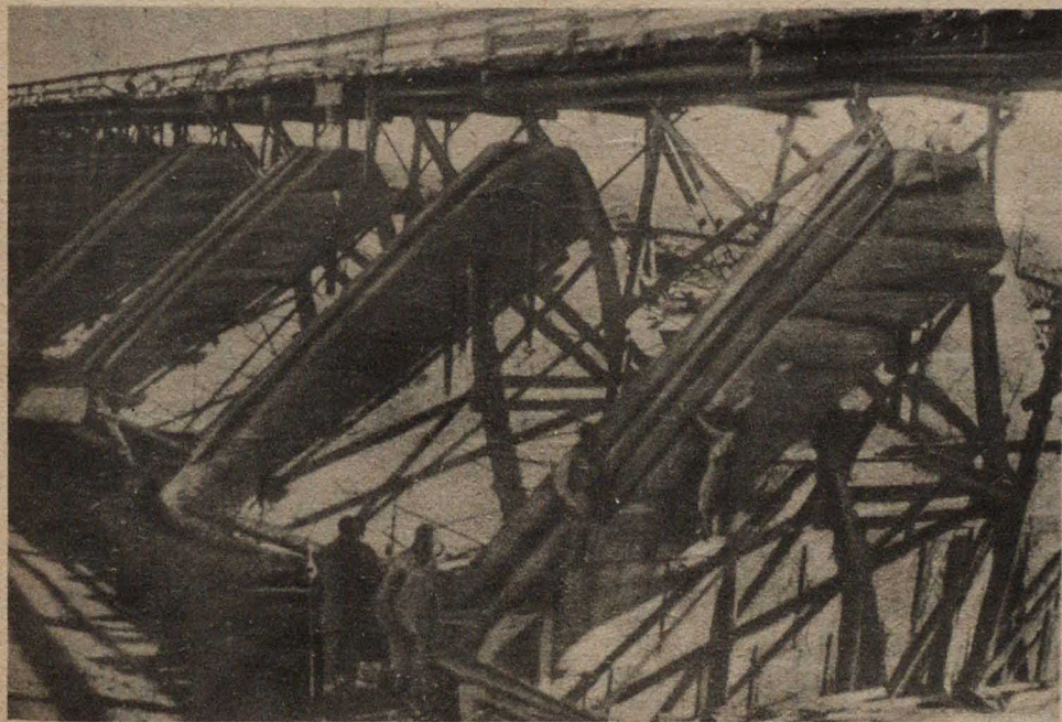
Последние бычки плотины освобождаются от опалубки
