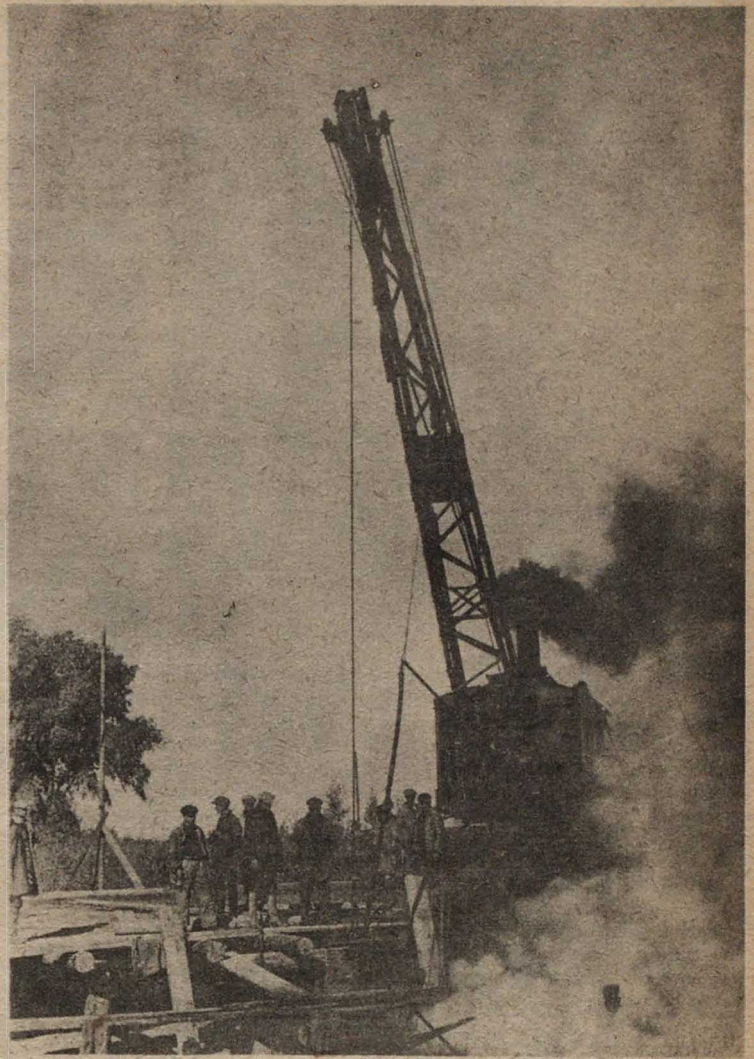
Забивка свай на плотине паровым молотом
