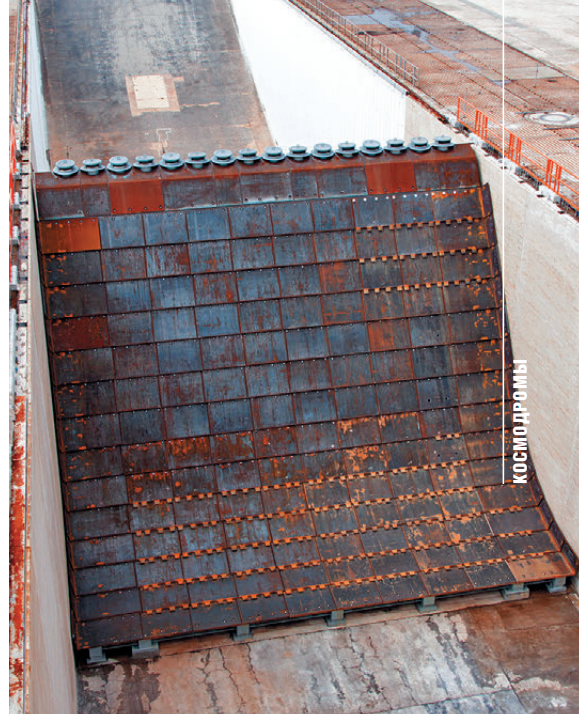
▲ Канал газовода на комплексе LC-39B
