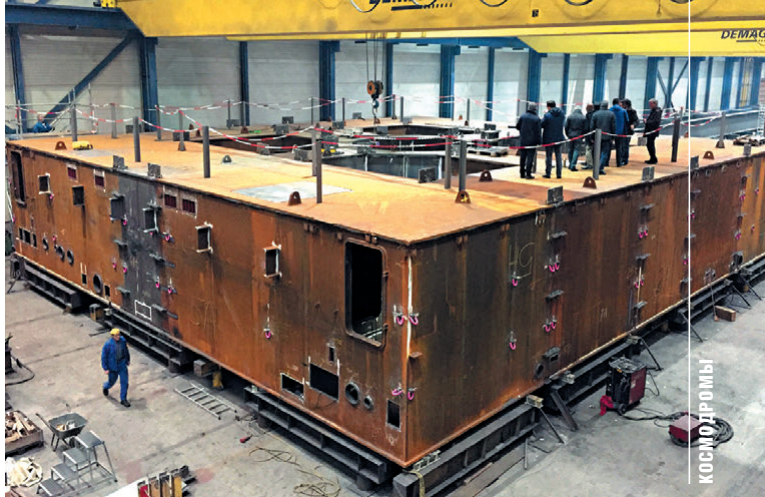
▲ Изготовление конструкции стартового стола для Ariane 6
