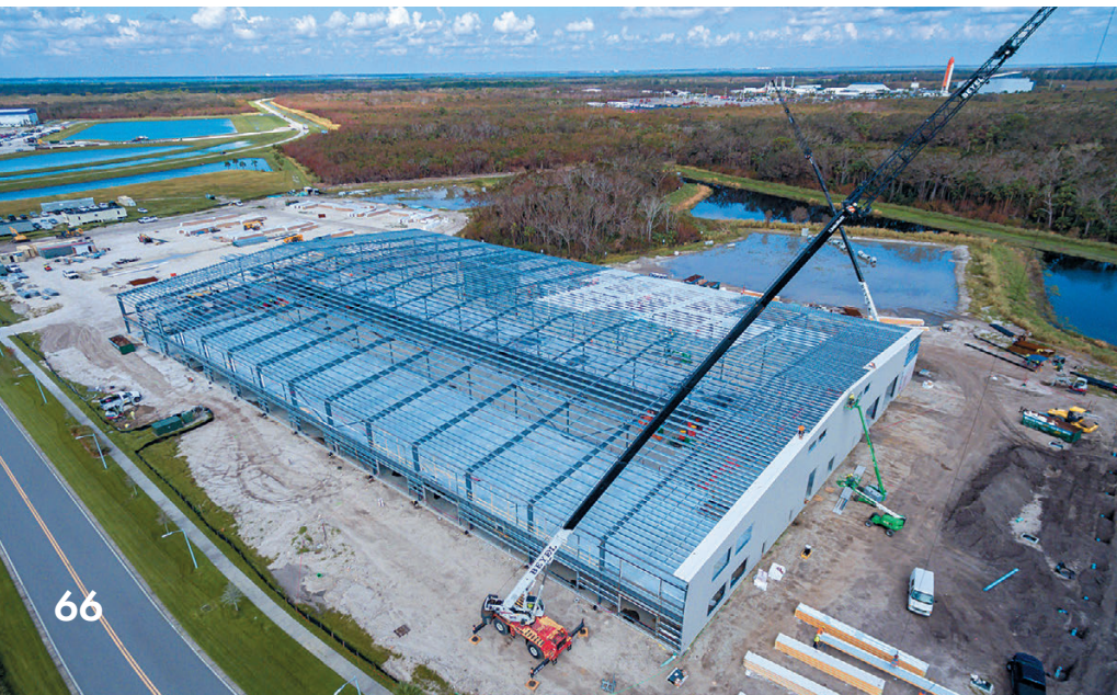
▼ Строительство завода OneWeb Satellites во Флориде идет полным ходом
