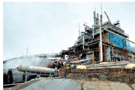
▲ Стендовая база КБХА готовится к огневым испытаниям прототипа метанового двигателя
