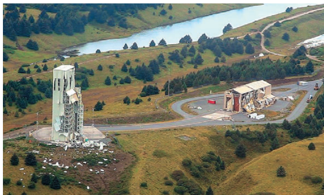
▲ Разрушенный взрывом ракеты стартовый комплекс
