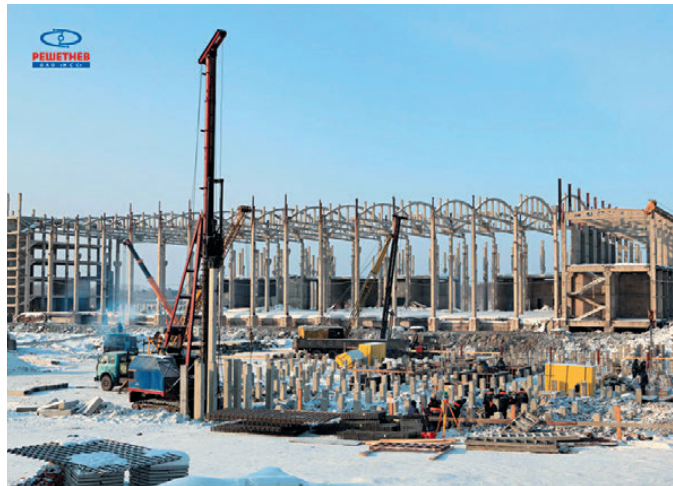
▼ Начало строительства монтажно-испытательного корпуса
