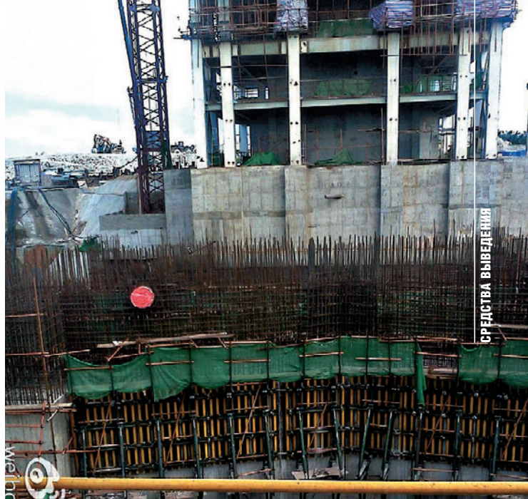
▲ Строительство стартового комплекса для РН CZ-5 на космодроме Вэньчан
