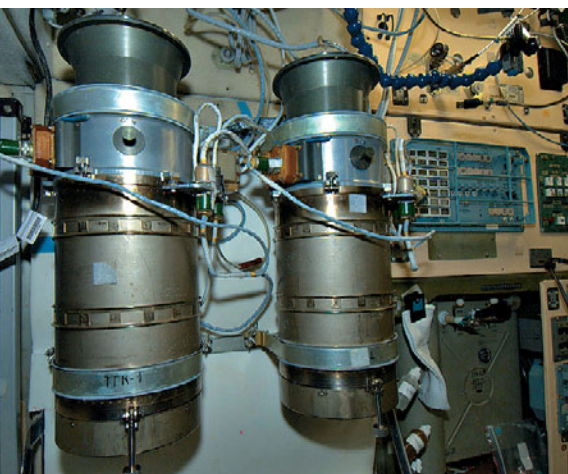
▲ OXYGEN-3: твердотопливные генераторы кислорода. На всякий аварийный случай
